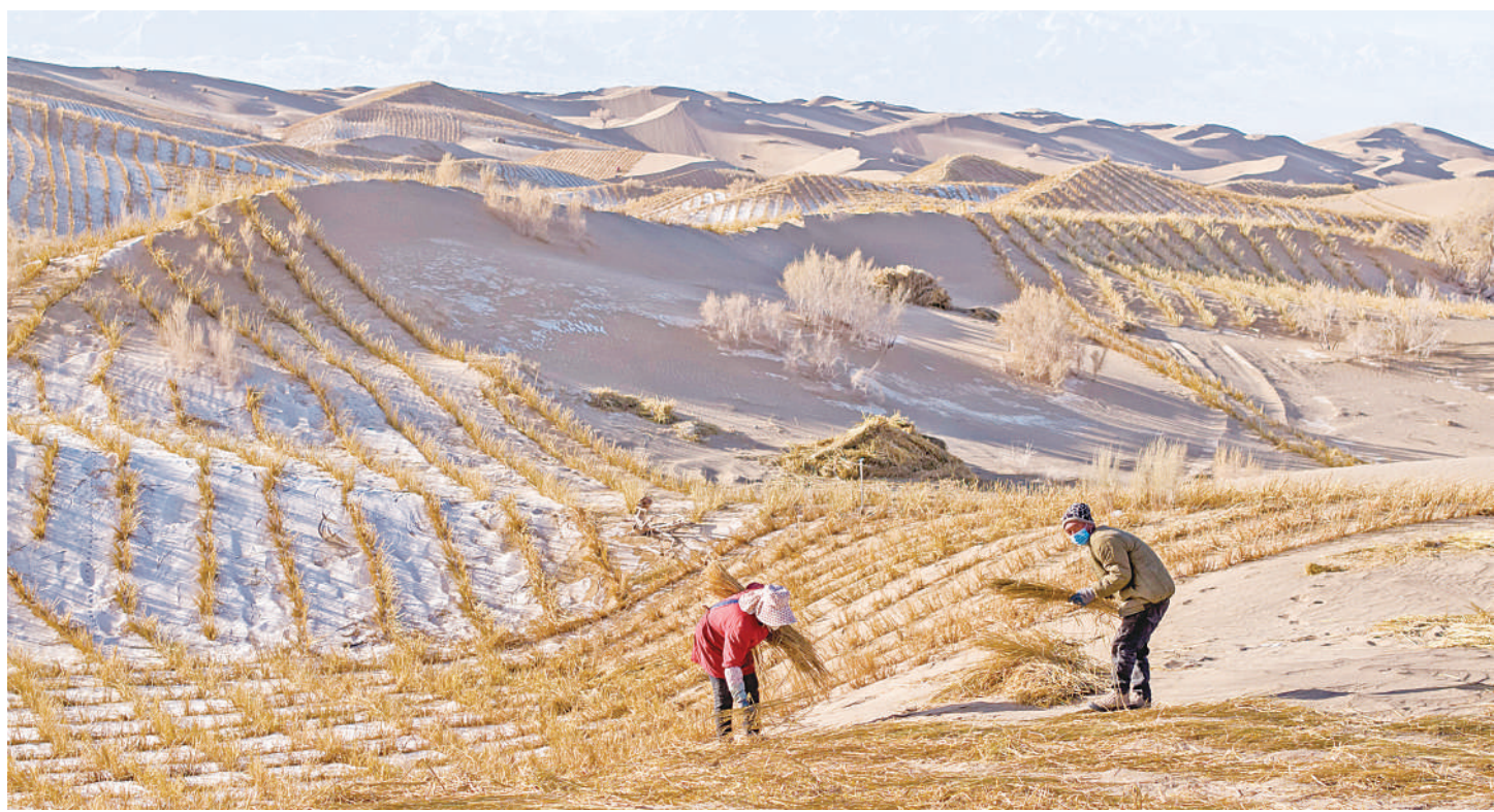
12月13日,施工人员在库姆塔格沙漠铺设沙障。一场冬雪过后,在甘肃省酒泉市阿克塞哈萨克族自治县的库姆塔格沙漠边缘,施工人员忙着铺设沙障,有序推进甘肃省酒泉市祁连山北麓阿克塞片区水源涵养与生态保护修复项目。
