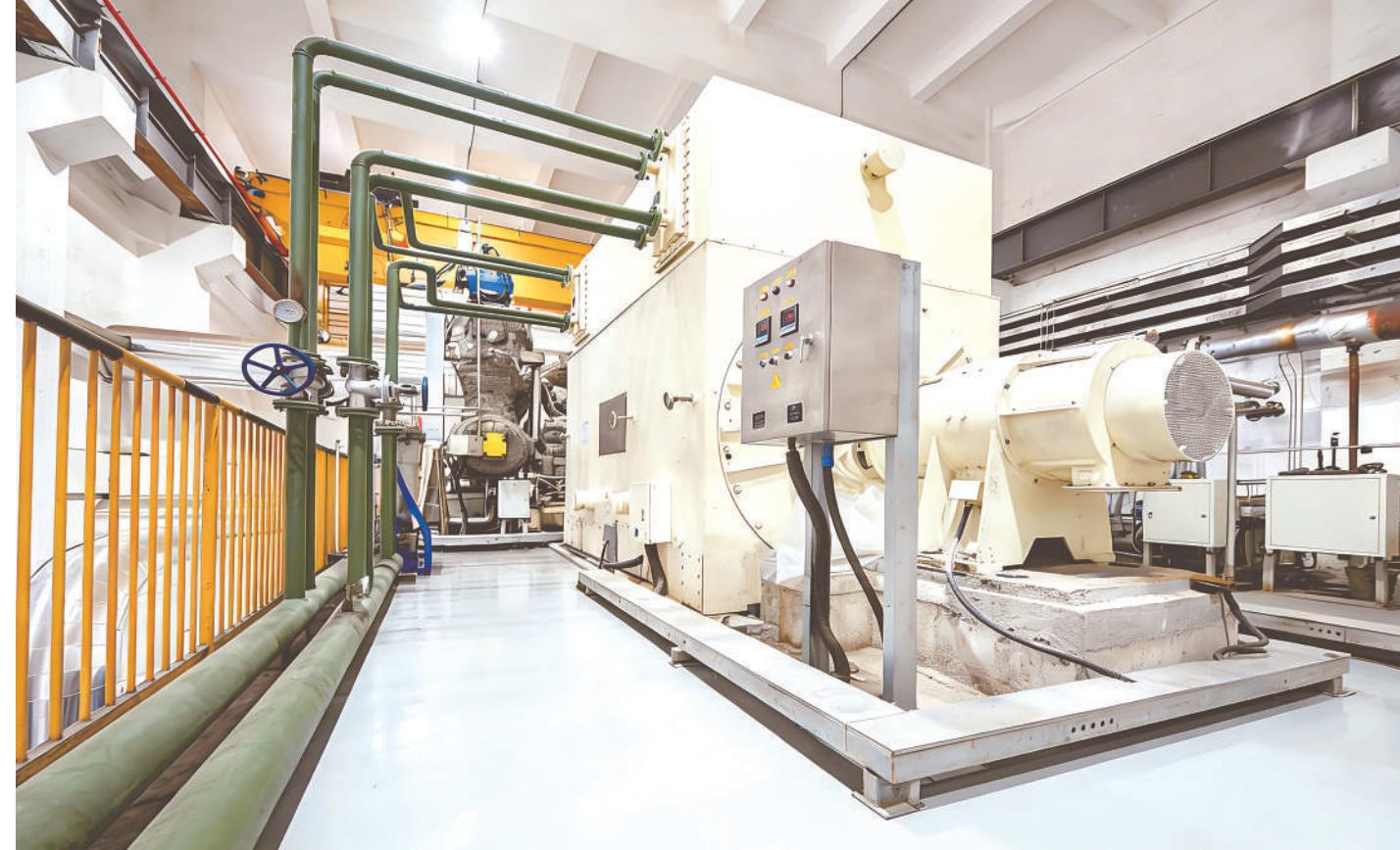
这是“超碳一号”的透平及发电机(资料照片)。12月20日,全球首台商用超临界二氧化碳发电机组在贵州六盘水首钢水钢集团成功商运,这也是超临界二氧化碳余热发电技术“超碳一号”的全球示范工程。“超碳一号”使用超临界二氧化碳作为循环工质,相比烧结余热蒸汽发电技术,发电效率提升85%以上,净发电量提升50%以上。新华社发
