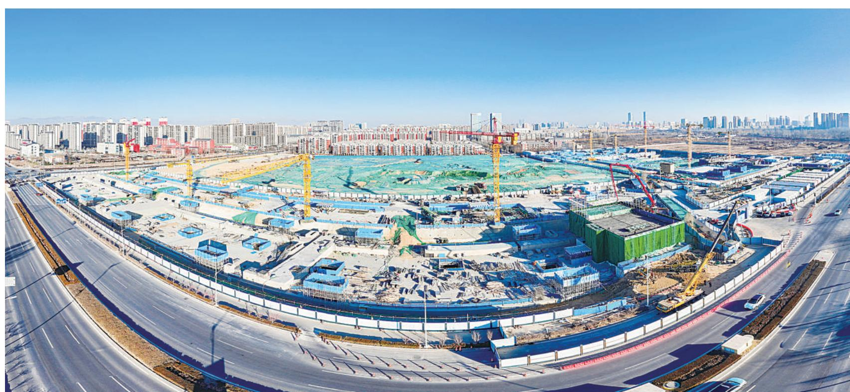
12月25日,银川市金凤区南部排水系统调蓄水池工程项目现场。作为银川市提升城市排水防涝能力的重点攻坚项目,这座地下封闭式调蓄水池池体长277.8米、宽37.8米,有效容积达7.5万立方米。
