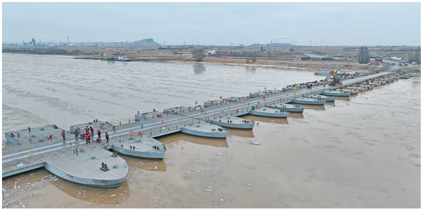
受持续低温降雪天气影响,黄河宁夏段预计1月5日后迎来今冬首次流凌。为确保行凌安全,1月3日,宁夏水利部门提前督促完成石嘴山河滨浮桥拆除工作。石嘴山河滨浮桥长218米、宽10米,位于黄河惠农段,此河段是宁夏防凌重点河段。
