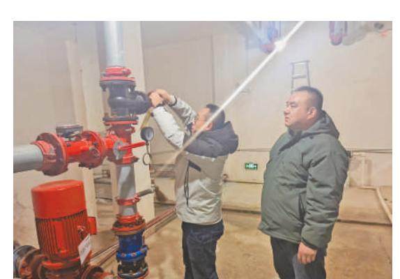
检查调试高低压压力开关。
