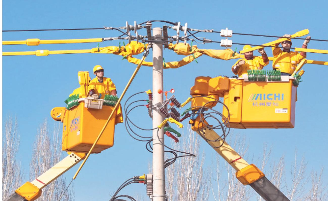
1月14日,工作人员在检修电路。当天,国网银川供电公司通过“两台中压发电车并机并网+两台绝缘斗臂车带电作业”方式,成功实现了检修期间约30个台区500余户客户不停电。随着贺兰县暖泉农牧场地区用电负荷不断增长及供电可靠性要求不断提升,国网银川供电公司对该分支线路2号杆加装自愈开关,以此实现该分支线路故障自动隔离、非故障区段快速复电、开关状态远程监控与遥控等,进一步提升线路安全可靠运行水平。
