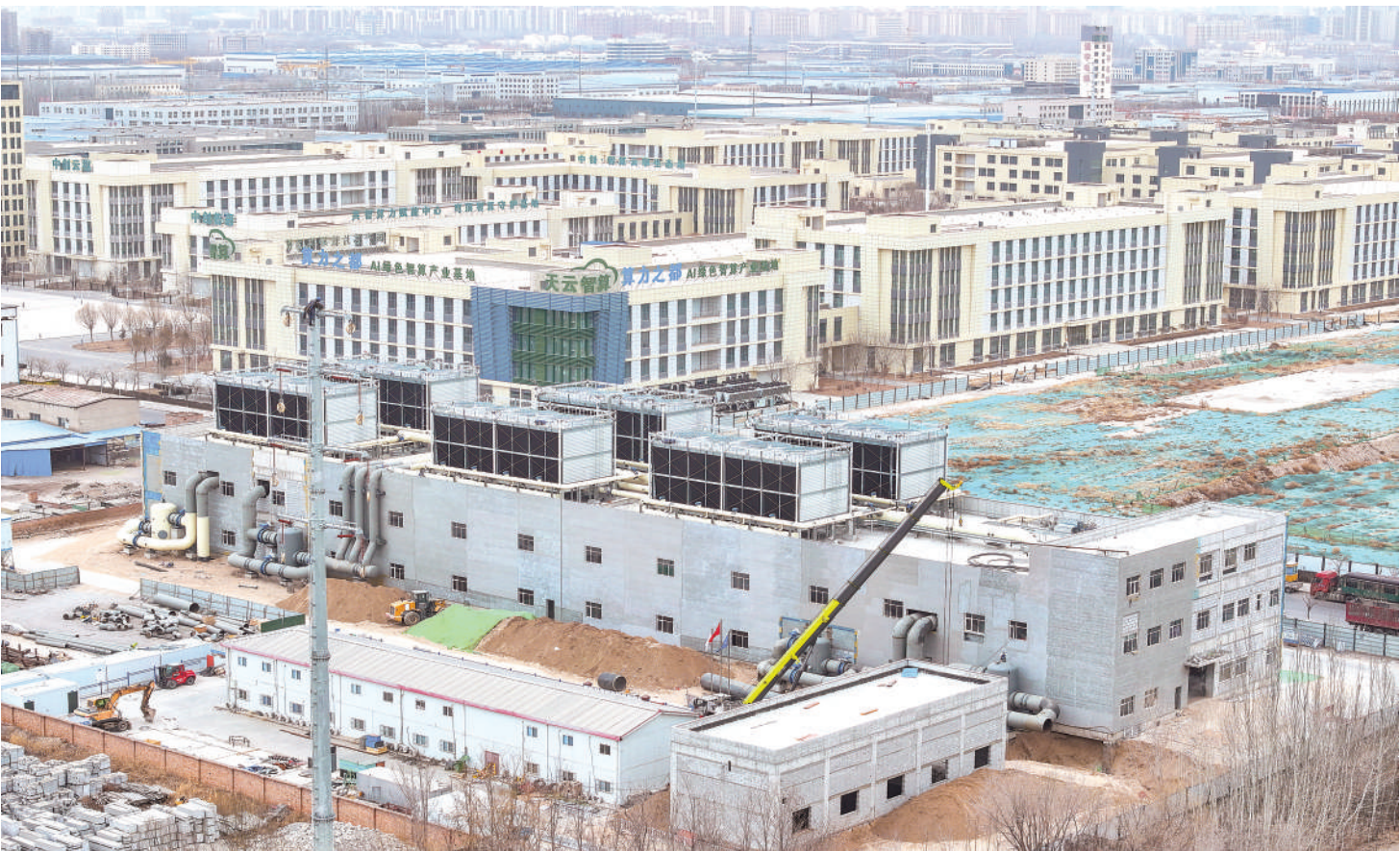
1月18日,在银川经开区的宁夏电投多能协同一体化示范项目现场,工人们协作推进土方回填、余热水管线路铺设等关键工序。该项目总投资4.6亿元,将为园区“AI港”提供稳定冷源的同时,兼顾城市供热功能。项目规划建设综合能源站堪称“算力降温神器”。该能源站最大制冷负荷可达80兆瓦,将实现全年不间断供热服务,为数据设备安全稳定运行筑牢能源保障,助力银川经开区“算力小镇”“图灵小镇”等载体构建完整的人工智能产业链闭环。
