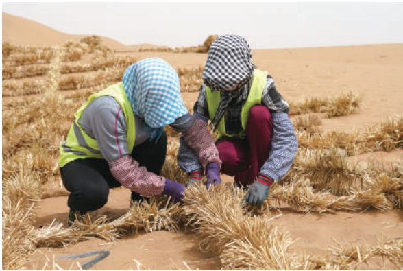
中卫市沙坡头景区腹地,治沙工人在铺设刷网绳式草方格沙障。
