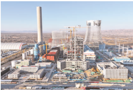
原州区六盘山电厂2×1000MW机组为国内领先的钢结构间冷塔工程。
