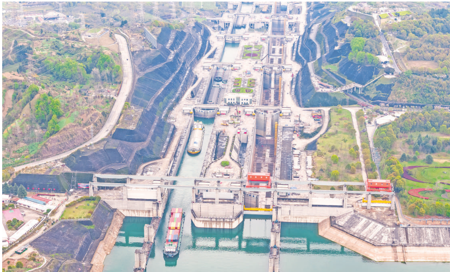
3月30日,湖北宜昌,三峡枢纽南线船闸正加紧检修,北线船闸有序通航(无人机照片)。三峡南线船闸2026年计划性停航检修于3月4日开工,计划工期45天,目前施工进度过半。检修期间,三峡枢纽通航保障有力,各类重点急运物资有序过坝。新华社发
