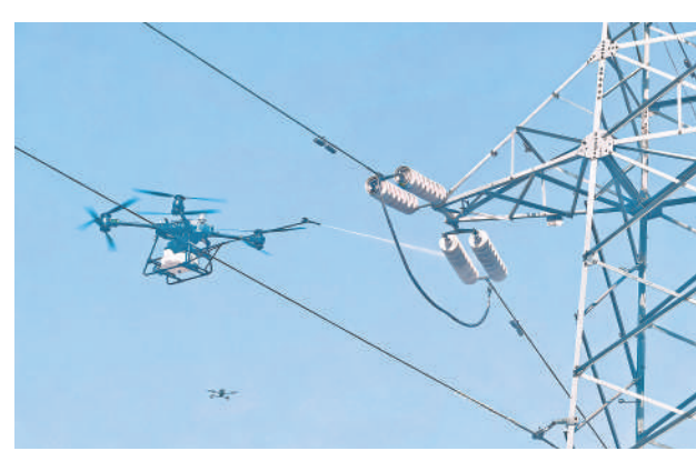
无人机进行冲洗作业。(图片由受访单位提供)
