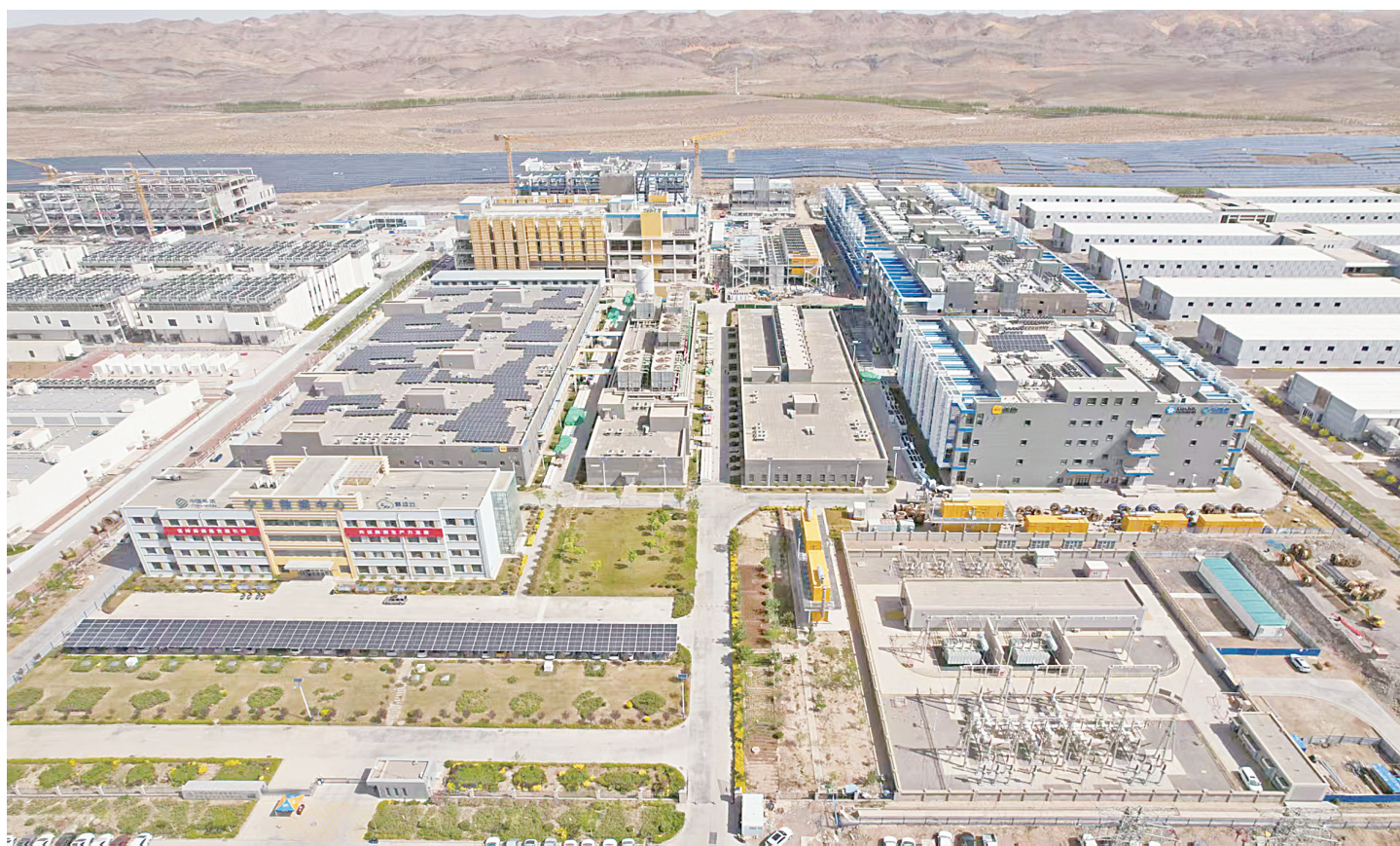
中国移动(宁夏中卫)数据中心B园区项目建设现场。
