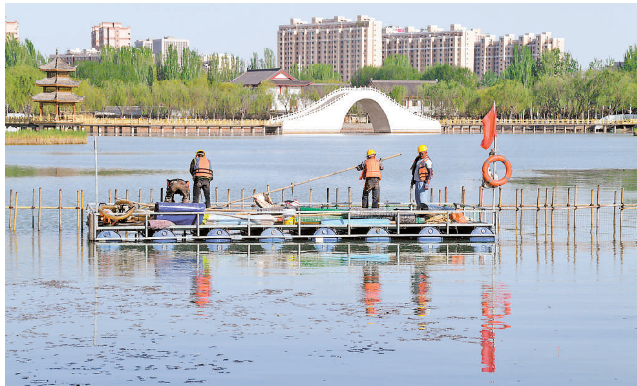
4月14日,银川宝湖公园,施工人员进行打桩作业。今年,宝湖公园将进行升级改造,打造集运动健身、戏水观鸟、生态康养于一体的“美丽河湖样板区”,为市民提供功能齐全的休闲观光打卡地。
