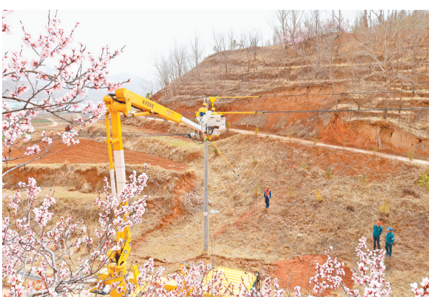
4月13日,在隆德县现庄乡石庙村,国网宁夏隆德县供电公司带电作业人员以“不停电”方式,为现庄乡蔬菜种植基地新增2台配电变压器接入电源,在不影响周边用户正常用电的情况下,保障该蔬菜基地抢抓农时、扩产增效。本报通讯员 戚国平 沙小平 摄
