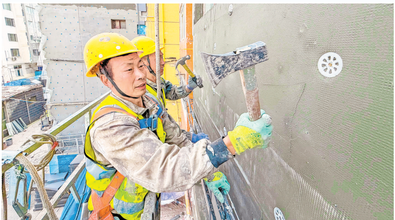
4月15日,银川市兴庆区和平里小区,工人给居民楼外墙铺设保温材料。据悉,兴庆区920个小区中,2000年底前建成的达723个。近年来,兴庆区持续推进老旧小区改造,截至目前已完成628个符合条件小区的改造工作。
