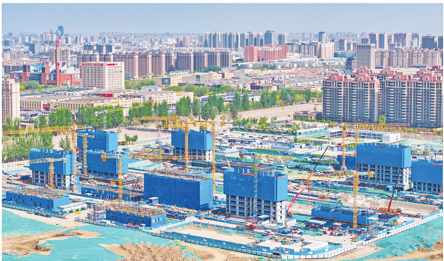
4月24日,银川市兴庆区南部零散城中村改造项目现场塔吊林立、建设正酣。作为银川市367个城市更新和民生保障重点工程之一,该项目涵盖两个城中村,占地190亩,总建筑面积27.2万多平方米,规划建设1754套安置房,同步配建商业综合体与市政配套设施,完善区域城市功能。本报记者 马楠 摄
