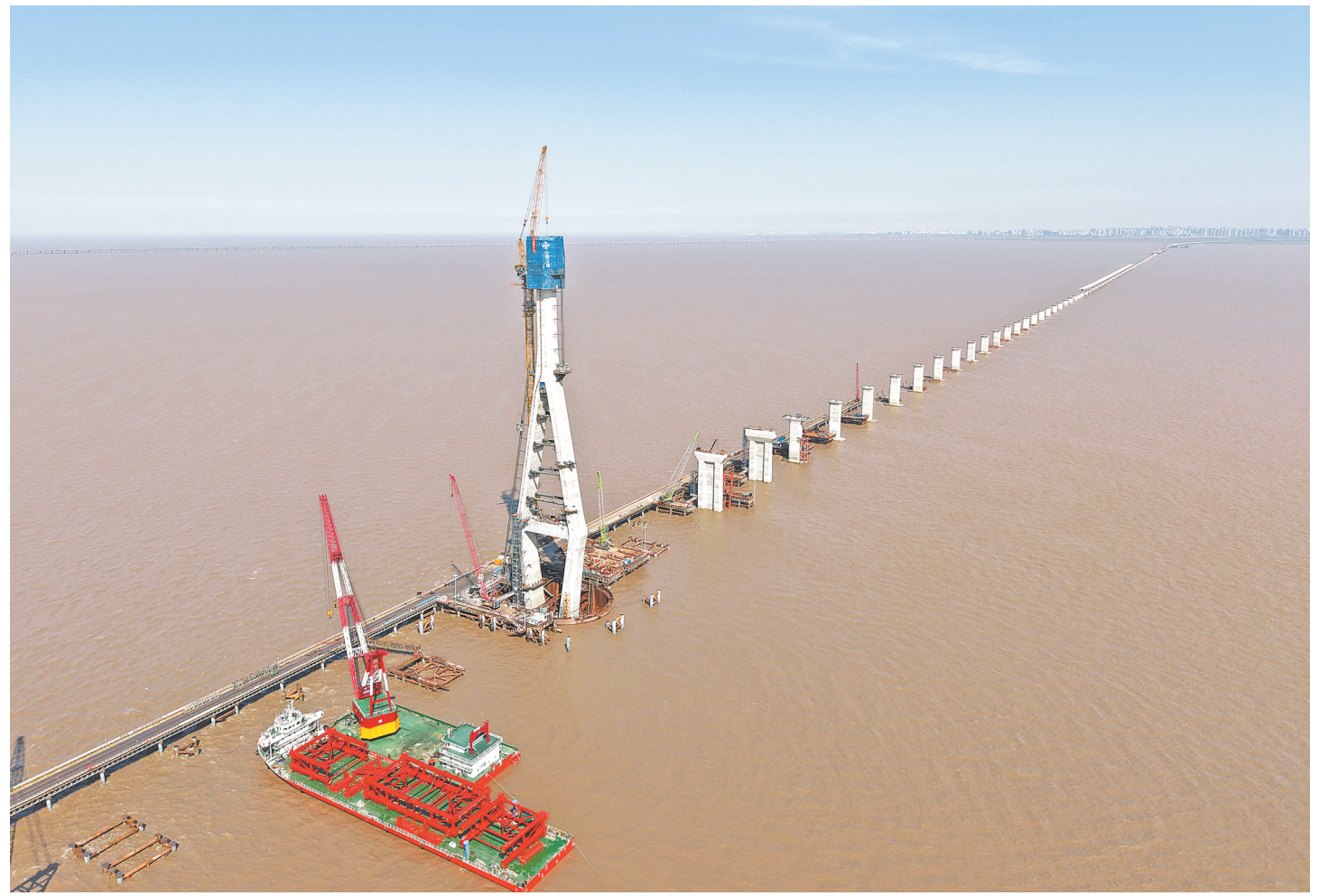
5月6日拍摄的杭州湾跨海铁路大桥南航道桥首座封顶主塔,主塔总高157.5米(无人机照片)。当日,由中铁上海建设公司建设管理、中交二航局承建的杭州湾跨海铁路大桥南航道桥首座主塔顺利封顶,标志着这一超级工程建设取得重大阶段性进展。 杭州湾跨海铁路大桥是新建南通至宁波高速铁路关键控制性工程,全长29.2公里,采用时速350公里双线无砟轨道设计,由北、中、南三座航道桥及海中引桥、浅滩区引桥共同组成。 新华社发
