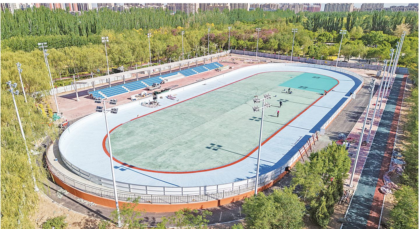
5月7日,位于银川市金凤区魏家巷公园内的银川市速度轮滑馆正在进行场地面漆涂装。该项目将于本月底正式建成投用,届时可满足赛事与市民健身双重需求。项目按照国家级赛事标准打造,建成一条周长200米的专业速度轮滑赛道。该赛道也将作为自治区第十七届运动会速度轮滑项目的主要赛场。
