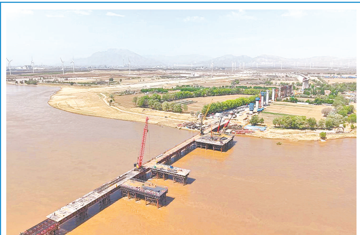
5月10日,惠农黄河铁路大桥首桩开钻。
