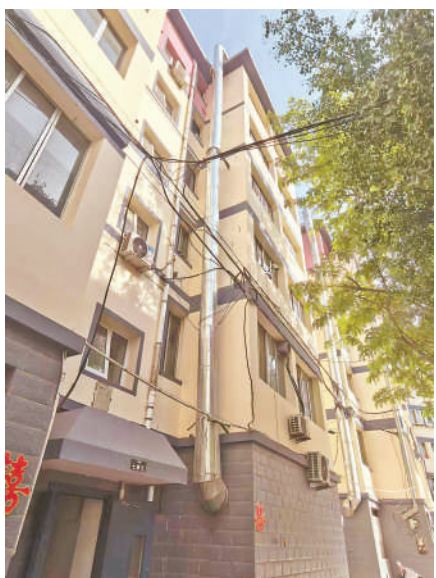
银川市兴庆区滨河家园二区内,一餐饮店的烟道架设在室外,通向二楼窗户外。
