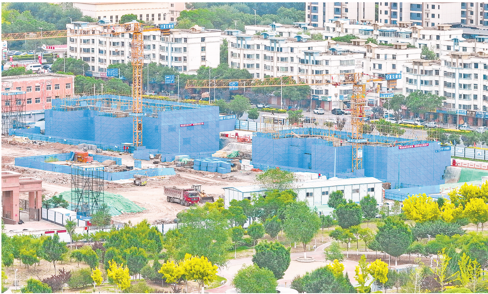
5月14日,银川市兴庆区北部零散城中村改造项目(满春小康村安置区)在紧张建设中。满春小康村安置区项目是兴庆区聚焦民生福祉、推进城市更新、加快北部零散城中村改造的重点民生安置工程,项目建成后,将彻底改善周边城中村居民的居住条件。本报记者 马楠 摄
