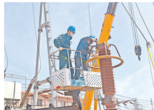
5月14日,检修人员进行220千伏母线大修工作。银川220千伏变电站是银川市西夏区的重要变电站,承担着保障周边居民、企业用电的重要职责,是连接区域电网的核心枢纽。5月以来,国网银川供电公司组织变电检修专业团队对该变电站开展220千伏母线综合检修工作,为迎峰度夏期间电网安全运行奠定基础。检修任务将于本月17日圆满完成。本报通讯员 马世瑞 摄
