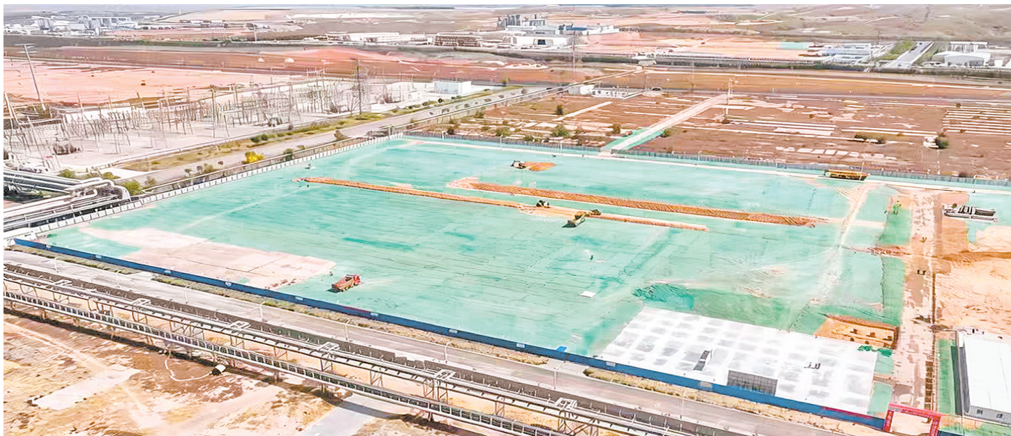
项目施工现场。
