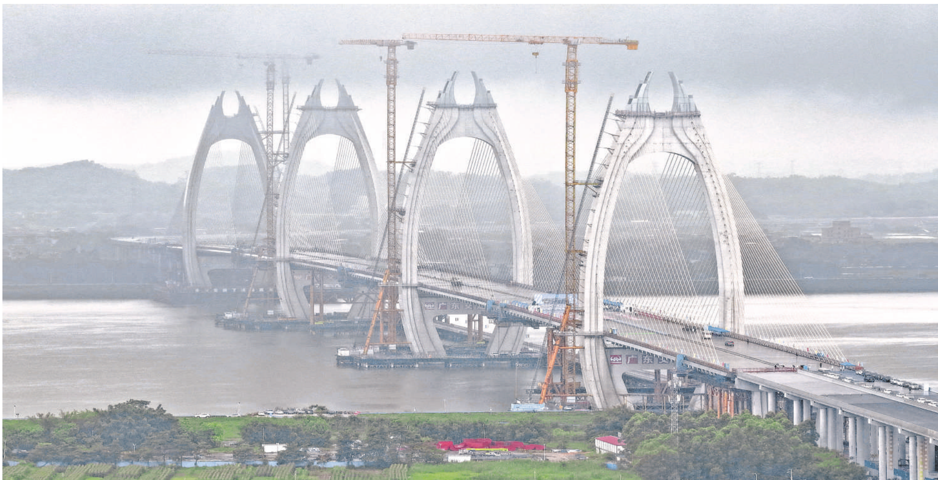
5月20日拍摄的广东清花高速北江特大桥(无人照照片)。当日,由中铁大桥局、中交路建承建的广东清花高速关键控制性工程——北江特大桥主桥顺利合龙。至此,清花高速主线实现全线贯通,为年底通车奠定基础。清花高速北江特大桥主桥全长1440米。作为广东省“十四五”重点建设项目,清花高速起于清远市清新区太和镇,终于广州市花都区炭步镇,全长约54公里,建成后将成为广清一体化又一交通大动脉。
