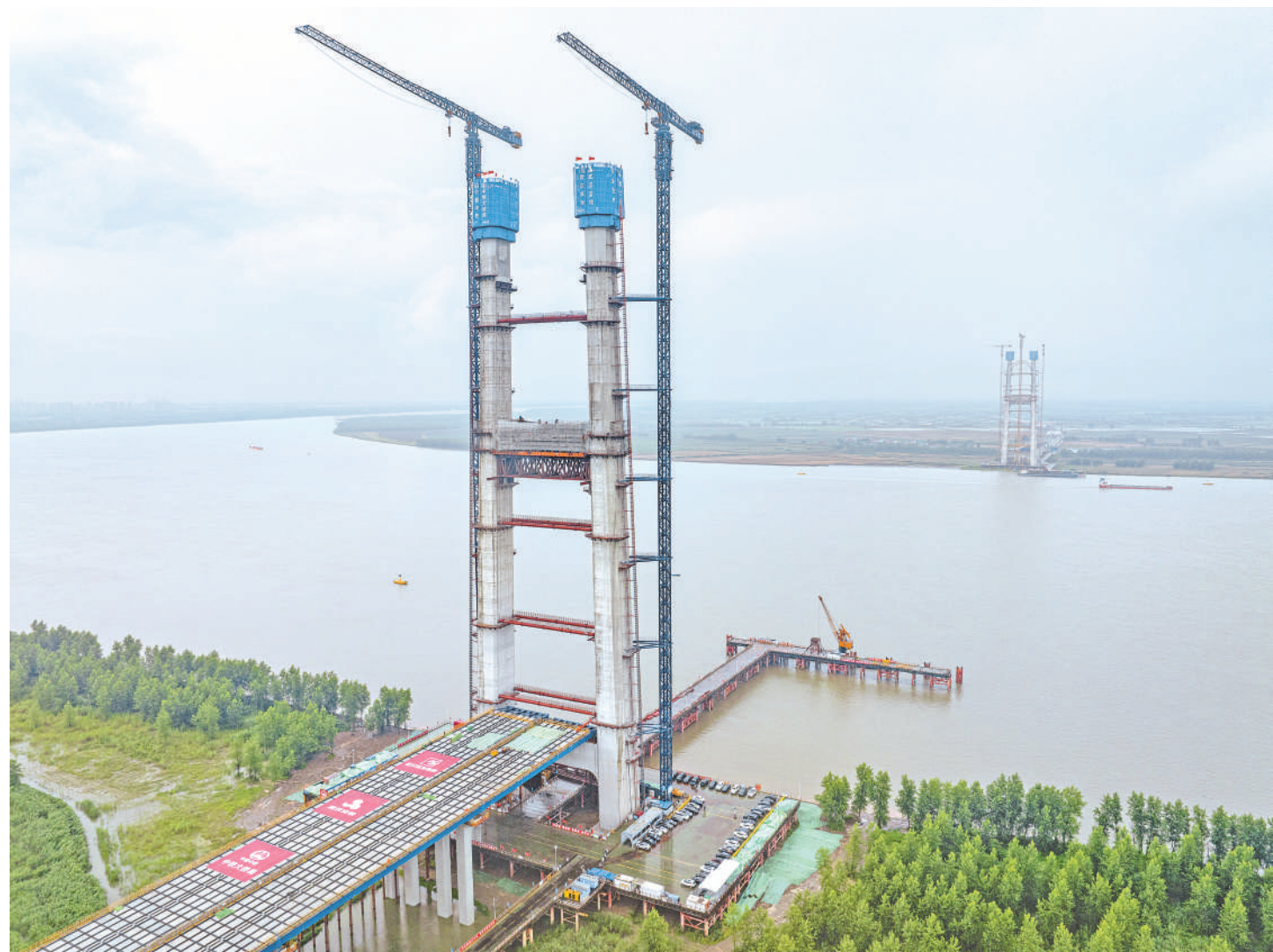
汉南长江大桥主塔同步封顶
