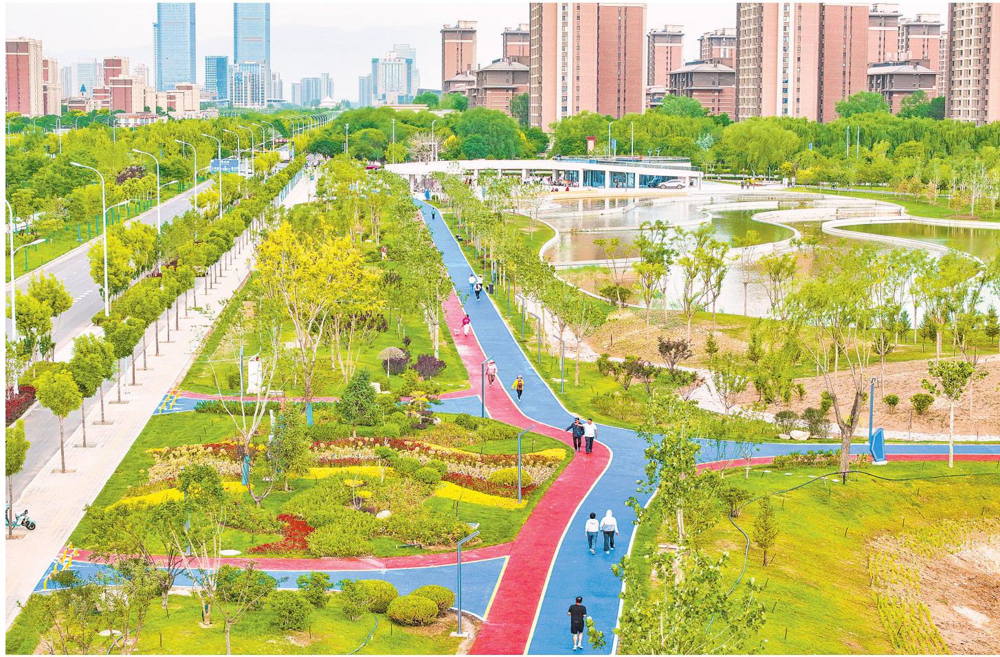
6月3日清晨，银川市金凤区王家湖海绵湿地公园草木葱茏，水系澄澈蜿蜒，不少市民漫步园中。目前，该公园已建成开园，成为银川海绵城市建设的全新标杆工程。项目贯通区域上下游水系，完善湿地滞蓄系统与植被缓冲带，有效涵养水土、净化水质。该公园的投用也补齐了城北片区生态休闲配套短板，实现周边居民“三百米见绿、五百米进园”的宜居愿景。
