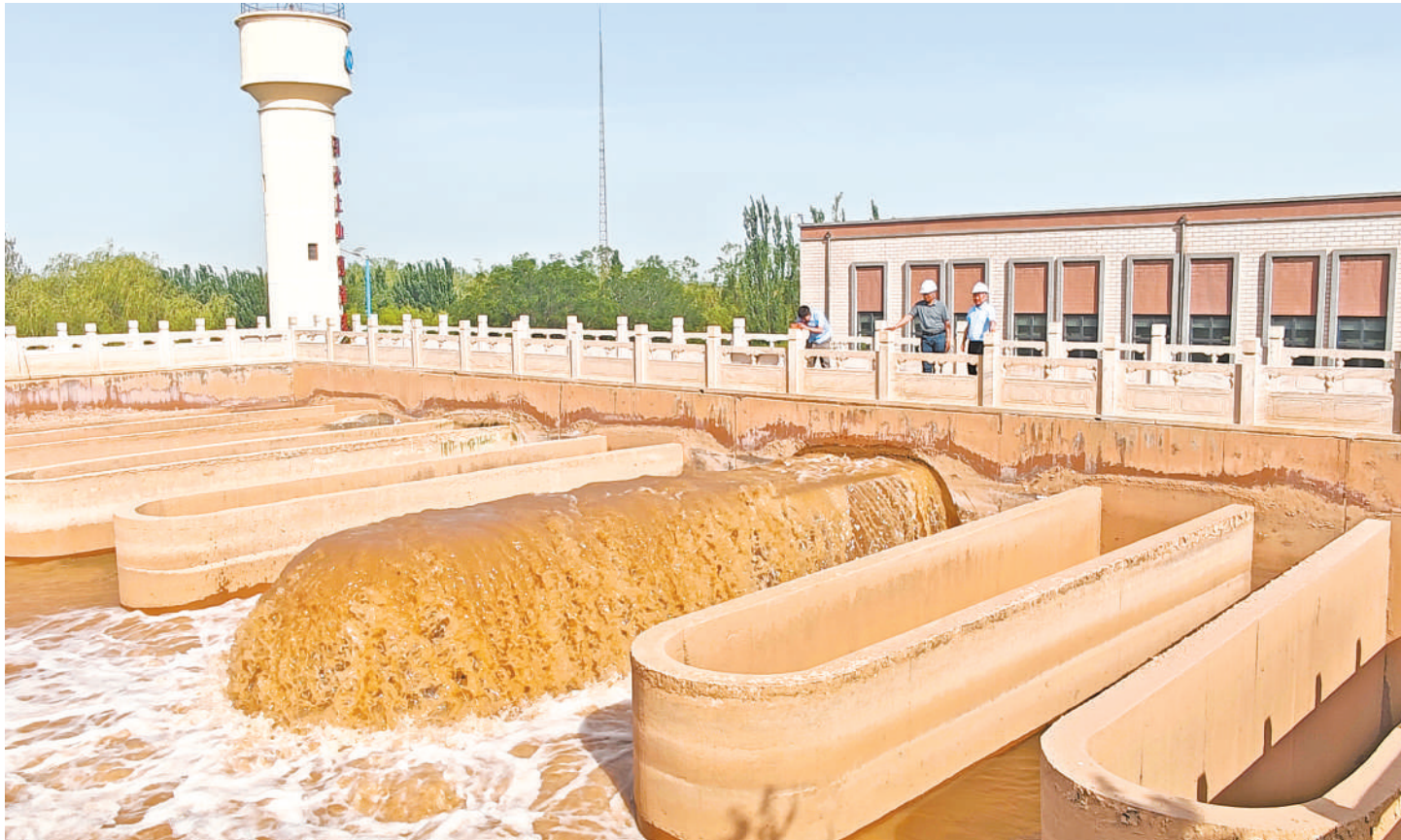
6月3日,盐环定扬水管理处一泵站3号大机开启,标志着盐环定扬黄工程2026年夏秋灌供水正式启动。盐环定扬黄工程是陕甘宁革命老区重要的水资源配置工程,承担着为陕西定边、甘肃环县及宁夏盐池、同心、红寺堡等干旱地区提供人饮、农业灌溉、工业生产及生态用水的重任,今年夏秋灌计划引水1亿立方米、供水0.92亿立方米。
