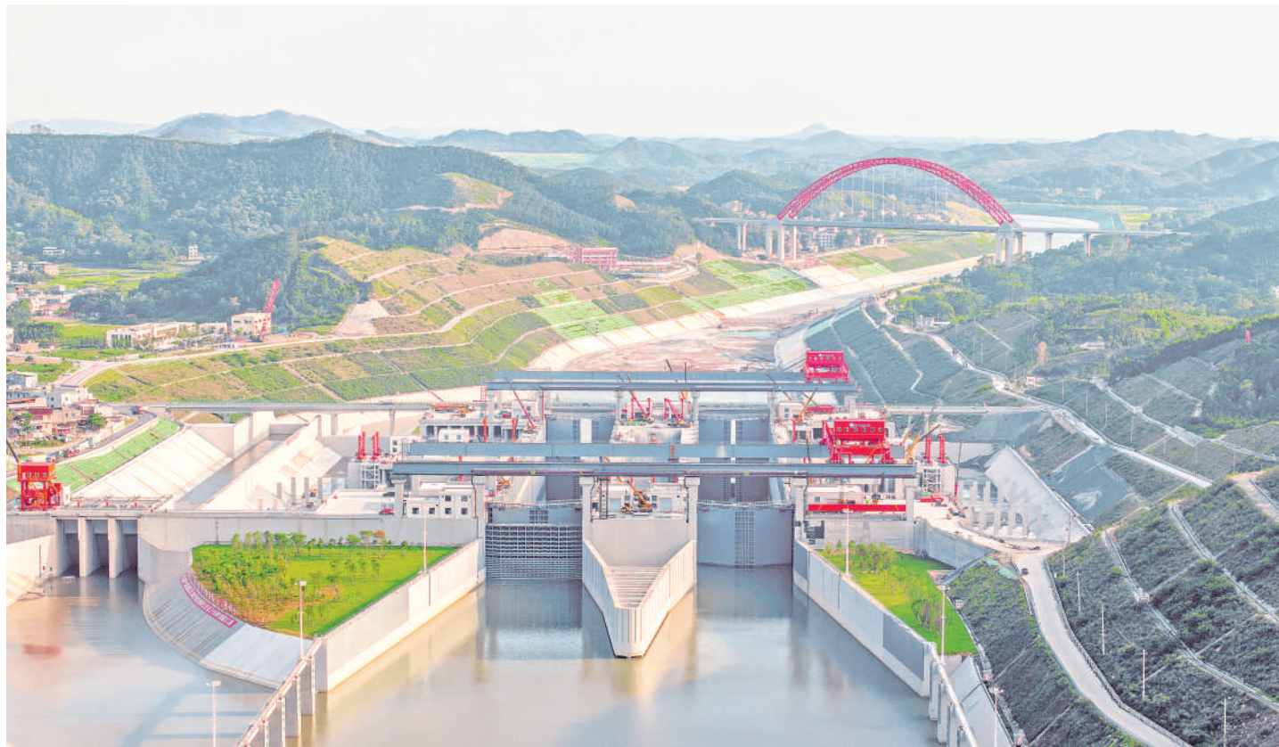
这是6月3日拍摄的广西平陆运河马道枢纽充水现场(无人机照片)。当日,随着平陆运河马道枢纽和企石枢纽正式开始充水,平陆运河全线通水,全面进入有水调试阶段。平陆运河是西部陆海新通道骨干工程,全长134.2公里,北起广西横州市平塘江口,经灵山县陆屋镇,沿钦江进入北部湾,作为新中国成立以来我国第一条国家层面统筹的通江达海的运河工程,平陆运河可通航5000吨级船舶,将于今年9月通航。新华社发
