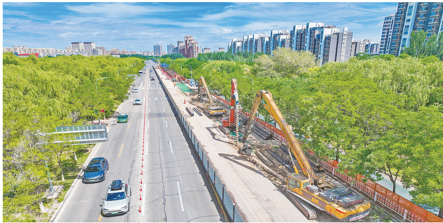
6月4日,银川市金凤区南部雨污分流改造二期工程建设现场。该项目总投资3954.84万元,建设工期120天,预计7月建成投用。工程投用后将实现区域雨污彻底分流,污水统一进厂处置、雨水就地收集资源化利用,从源头上化解片区内涝隐患,降低污水处理运行负荷。
