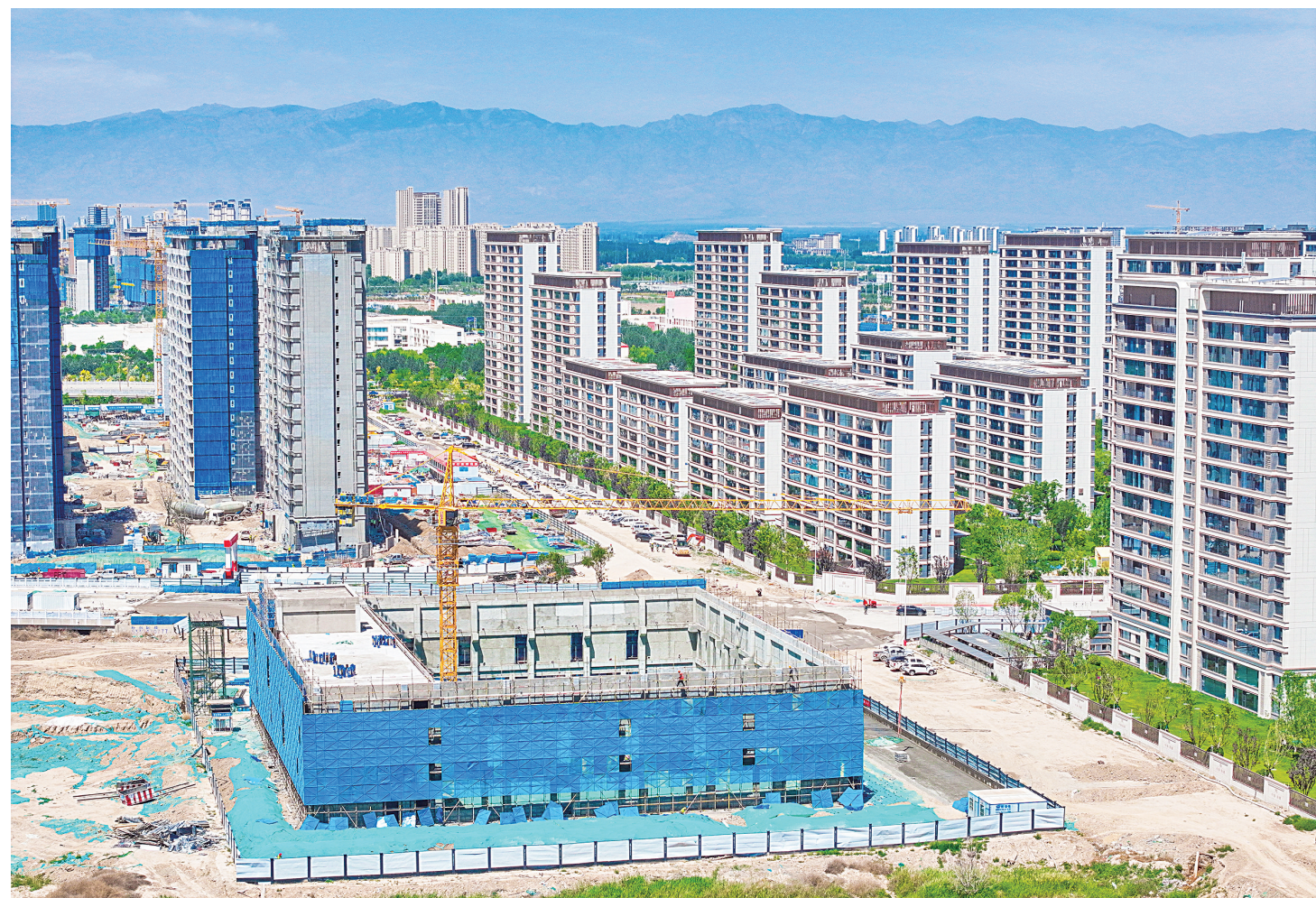
6月5日，银川市金凤区城北的重点民生项目——凤凰全民健身中心正在施工建设。这座全民健身中心主打“全民适配、多元便民”。预计10月竣工并对外开放，届时将填补金凤区城北片区缺少综合性健身场馆的空白，进一步打造城市“15分钟健身圈”。 本报记者 马楠 摄
