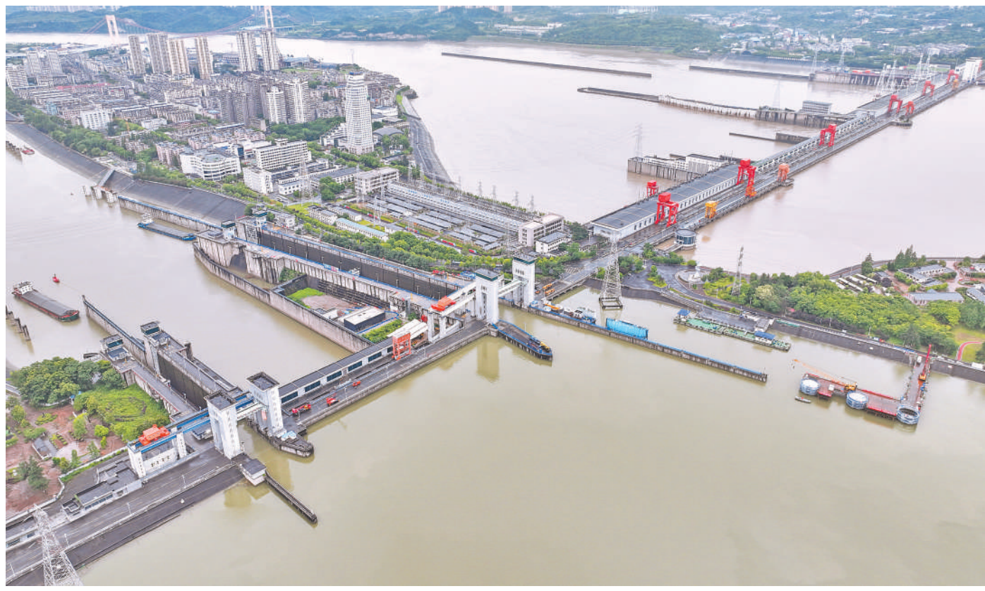
6月8日拍摄的三峡水运新通道工程葛洲坝航运扩能施工现场。
