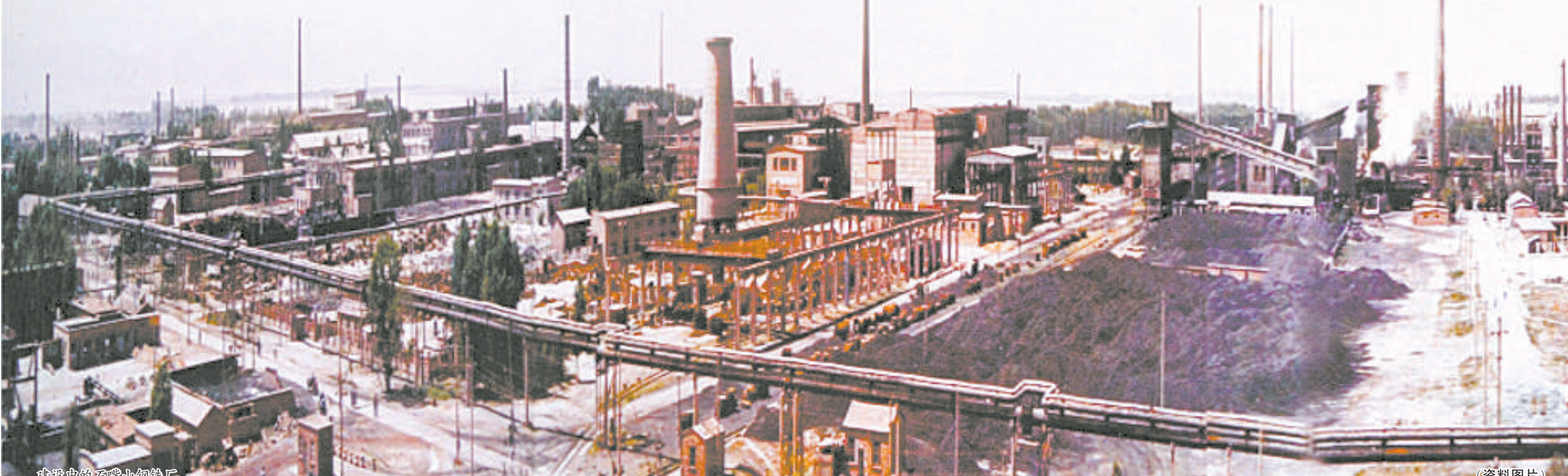
建设中的石嘴山钢铁厂。
