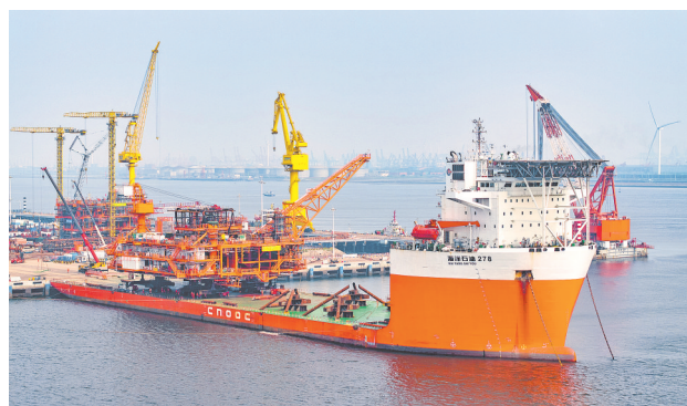
这是6月16日拍摄的渤中26-6油田开发项目(二期)平台完工装船现场(无人拍照)。当天,随着最后一座平台在天津市滨海新区成功装船,全球最大变质岩油田——渤中26-6油田开发项目(二期)全部平台陆地建造完工,为油田按期投产奠定基础。新华社发
