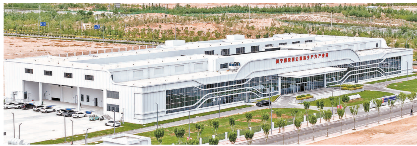
位于宁夏中卫市宁东镇闽宁新质生产力产业园内的星汉智能科技(宁夏)有限公司新厂区。作为福建省大数据集团落地产业园的核心项目,新厂区于今年5月初投用,为区域发展注入数字动能。 本报记者 左鸣远 摄
