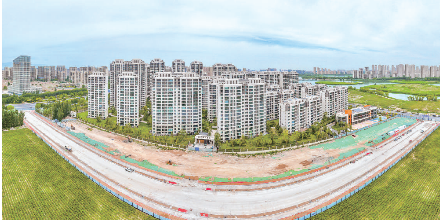
6月17日，银川市金凤十一路（正源街—灵水街）道路整体面貌初显，项目建设进入收尾冲刺阶段。道路建成后，将进一步补齐金凤区南部基础设施短板，完善区域路网结构，方便周边居民出行。本报记者 马楠 王洋 摄
