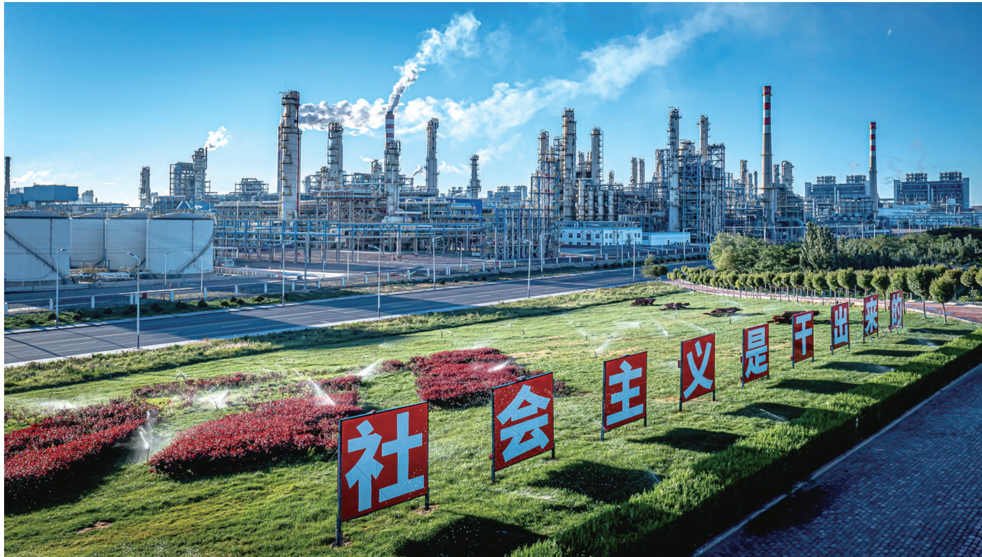
煤制油装置区。
