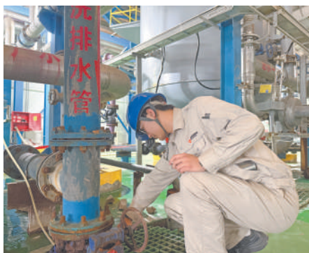
6月24日,国家能源集团宁夏煤业有限责任公司工作人员测试弱酸阳离子交换器出水的pH值。 本报记者 徐琳 摄
