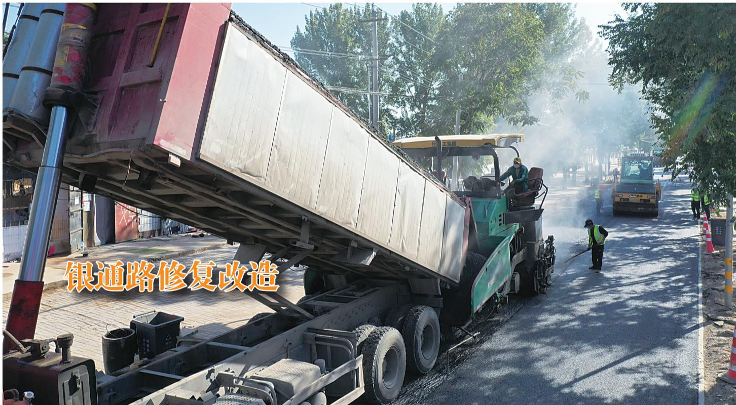
10月10日,在银川市兴庆区银通路,施工人员正在对路面进行修复改造。银通路是连接银川市区与兴庆区通贵镇的重要公路,随着交通压力的增加,路面出现不同程度的裂缝、坑洼等病害。今年9月中旬,银川市公路管理处对银通路进行修复改造,重新铺筑沥青混凝土面层,同时完善沿线交通安全设施。工程项目里程全长12.358公里,起点位于银通路与燕庆街交叉口,终点位于银通路与永通公路平交处,概算总投资1250万元,预计10月底完工。
