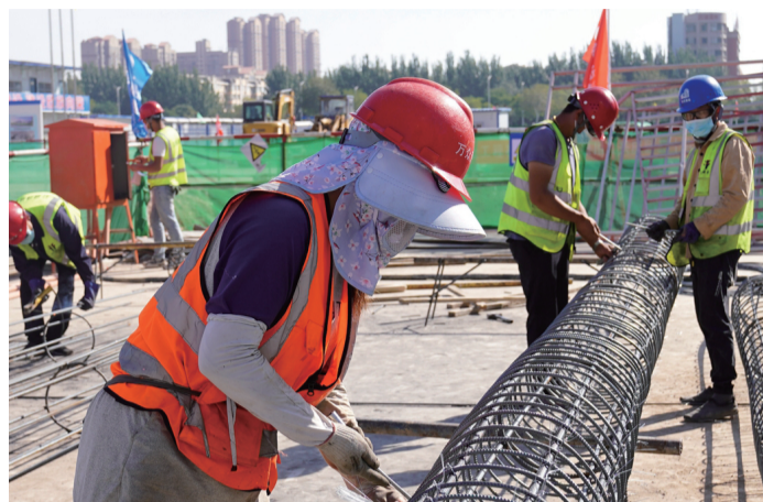
在兴庆区第三十六小学建筑工地，工人正加紧施工。 本报记者 高晓刚 摄
