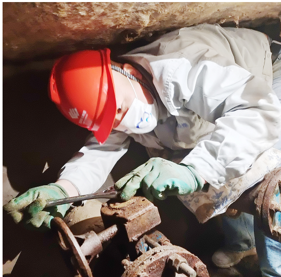
运维人员正在维修更换老旧阀门。魏钰妍 摄
