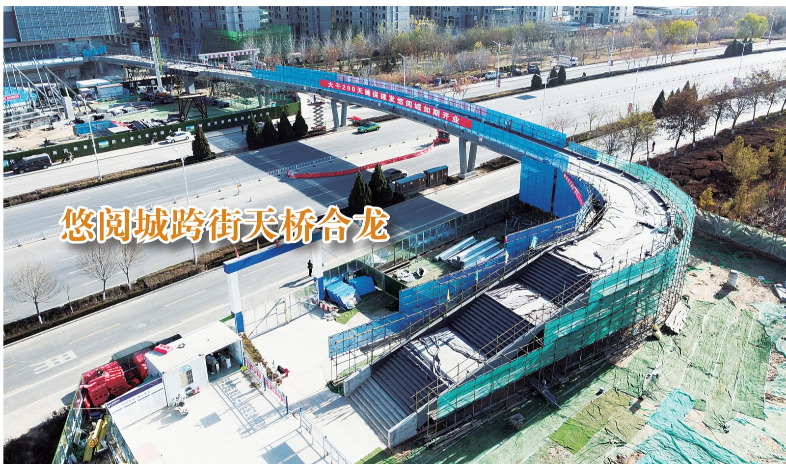
11月25日,俯瞰已合龙的银川市金凤区悠阅城跨街景观天桥。据了解,该过街天桥全长185米,宽6.5米,桥体两端设置LED大屏,连通购物中心与银川文化园及周边住宅区,项目建成后能让车流快速通行正源南街,形成立体高效的交通网络体系。
