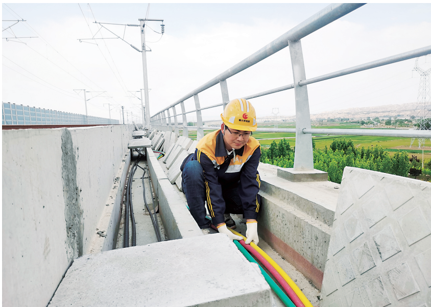
刘文清对银兰高铁中兰段供电“主动脉”——电力贯通电缆进行验收。 中国铁路兰州局集团有限公司银川供电段供图
