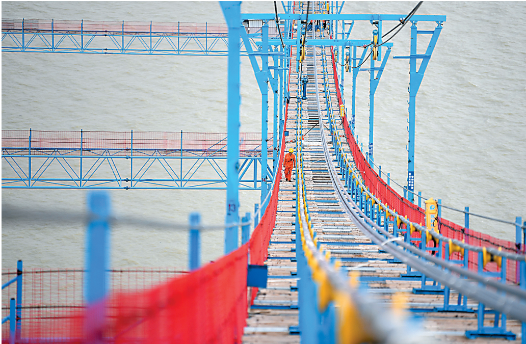
工人在深中通道伶仃洋大桥海上施工猫道上行走(2022年6月7日摄)。深中通道预计2024年建成通车，采用东隧西桥方案，全长24公里，集“桥、岛、隧、地下互通”为一体，是粤港澳大湾区超级跨海集群工程，建成后将作为联系珠江口东西两岸的直联通道。 新华社发
