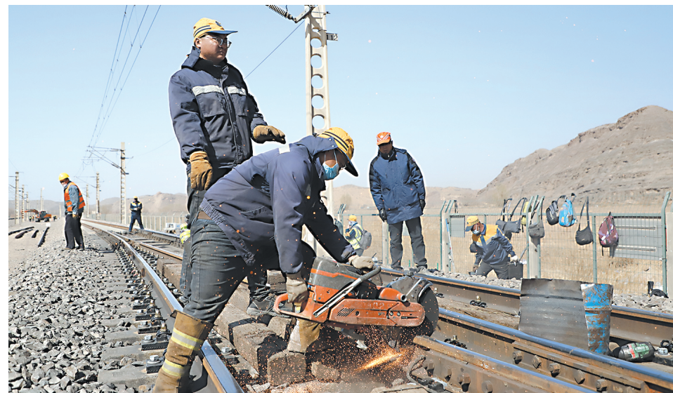
钢修组切割钢轨。中卫工务段供图
