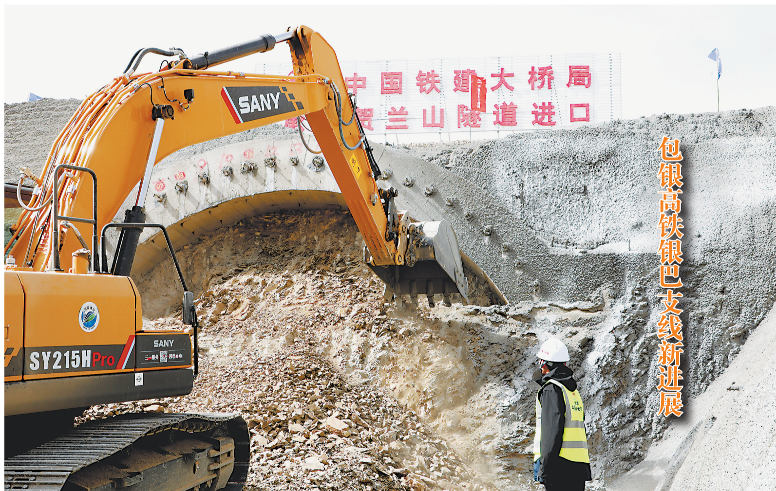
3月15日,由中国铁建大桥局承建的包银高铁银巴支线建设进展顺利,该路段重点控制性工程——贺兰山隧道进口正式进洞施工。宁夏日报记者 赵磊 摄
