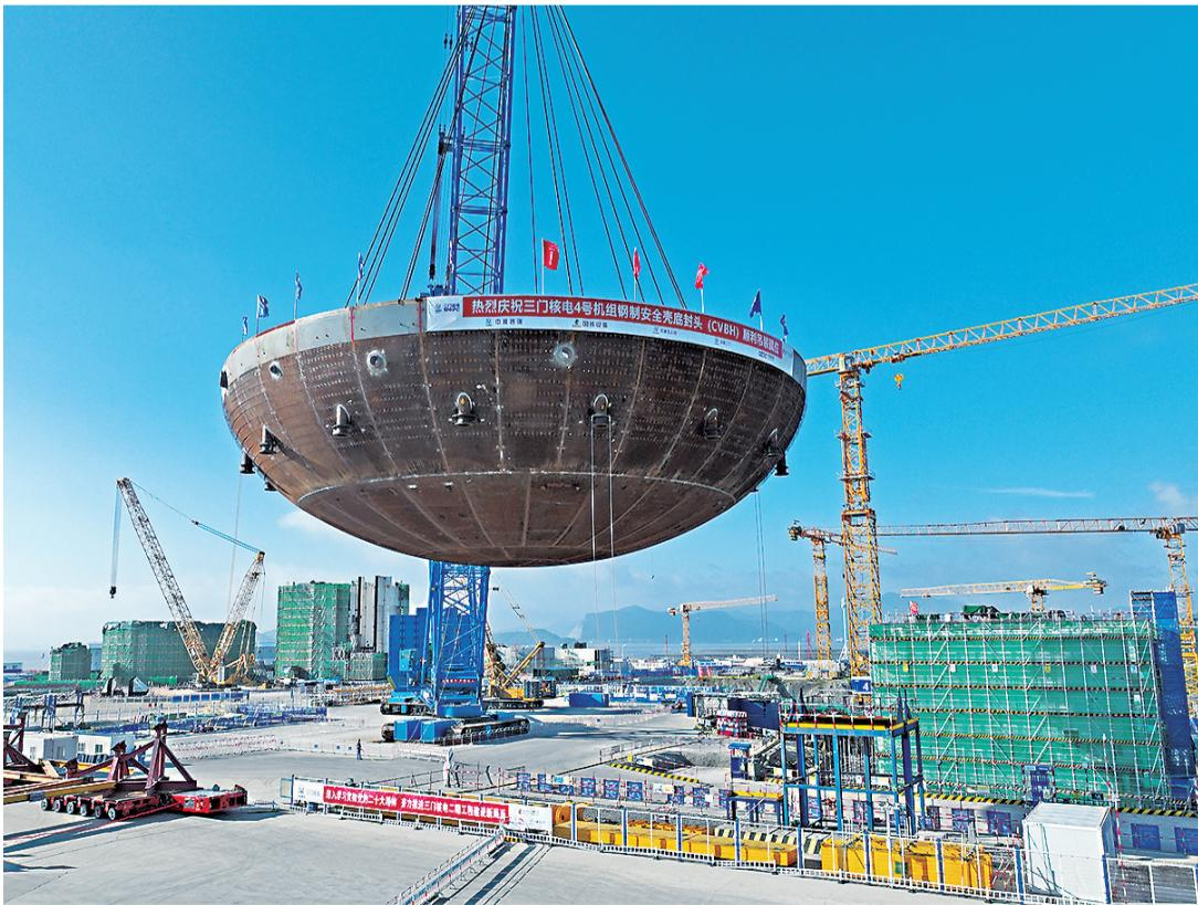
浙江三门核电二期工程4号机组核岛钢制安全壳底封头吊装就位
