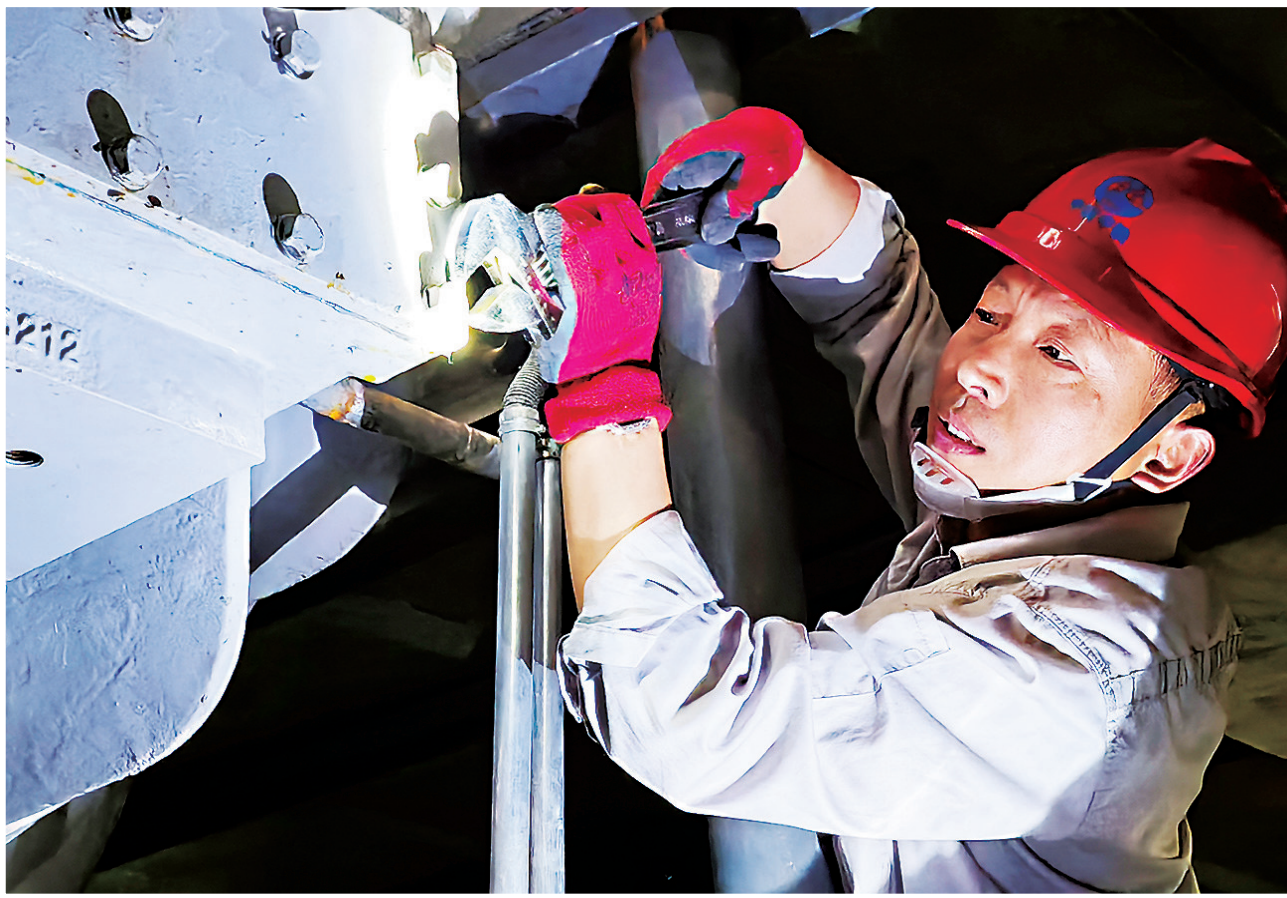
邵国华紧固离心泵泵体螺帽。 金沙湾取水泵站供图
