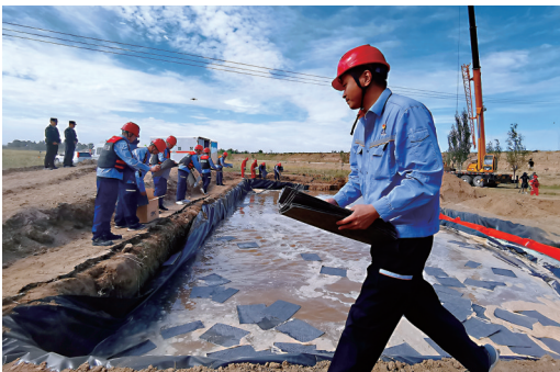
污染处置组用吸油毡收集污染物。
