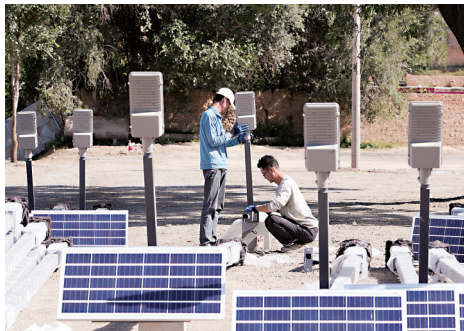
工人在球场周围的空地上调试安装太阳能路灯。
