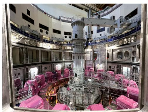
11月23日在位于法国圣保罗-莱迪朗斯的国际热核聚变实验反应堆(ITER)建设现场拍摄的安装中的托卡马克装置。新华社发
