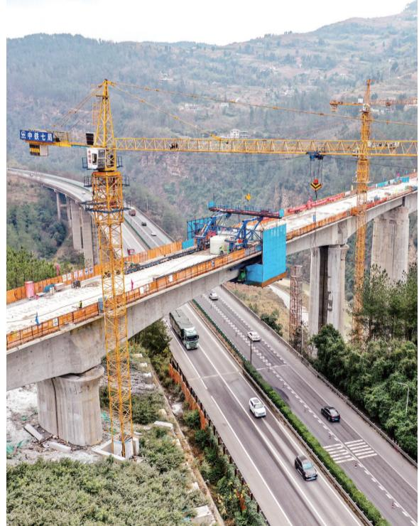
这是1月15日拍摄的石梁河双线特大桥施工现场。当日，随着最后一方混凝土浇筑完成，由中铁七局集团有限公司承建的渝湘高铁重庆至黔江段石梁河双线特大桥全桥顺利贯通。石梁河双线特大桥位于重庆市武隆区，是渝湘高铁重庆至黔江段控制性工程，大桥全长936.05米，是目前国内跨度最大、墩身最高的T构高铁桥。
